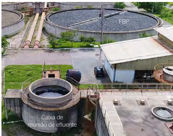
Figura 2 – Caixa de reunião de efluente de reatores UASB e Filtro Biológico Percolador (FBP).
