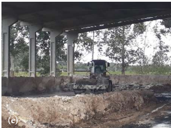
Figura 3 – Alternativas de homogeneização do lodo com a cal: (a) manual; (b) betoneira; (c) maromba; (d) enxada rotativa; (e) retroescavadeira; (f) misturador mecânico horizontal (eixo central e pás do tipo arado com tempo de detenção mínimo de 3 minutos).
