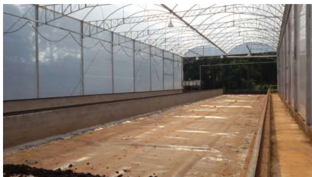
Figura 2 – Sistema de secagem e compostagem em estufa, ETE Lageado, Botucatu, SP.
