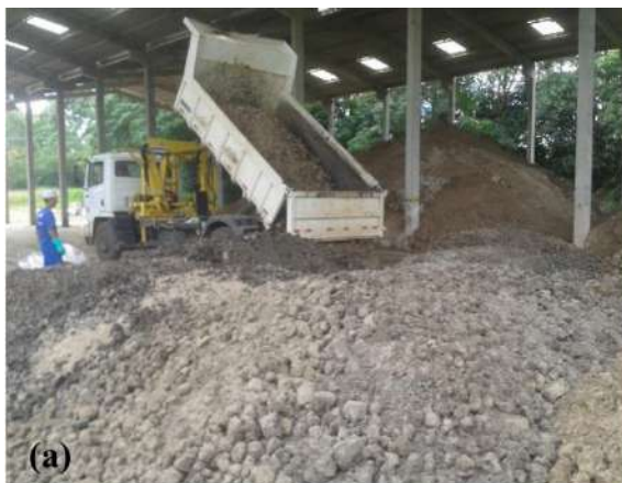
Figura 4 – Estocagem de lodo caleado em lotes de (a) grande porte e (b) pequeno porte.
