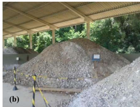
Figura 4 – Estocagem de lodo caleado em lotes de (a) grande porte e (b) pequeno porte.
