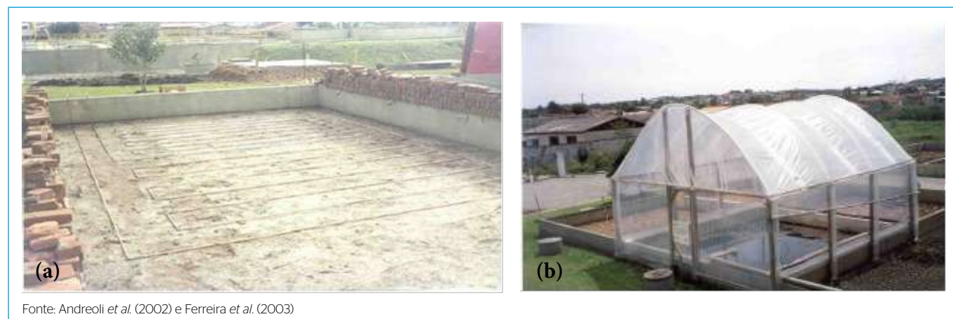
Figura 6 – Leito de secagem convencional modificado para promover a secagem e higienização do lodo de forma simultânea: (a) tubulação de cobre colocada na camada drenante de um leito de secagem para a circulação do óleo aquecido; (b) cobertura do leito de secagem modificado com estufa plástica
