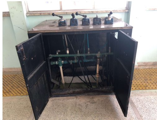
Mesa de comando de filtro obsoletas/ péssimo estado de conservação
