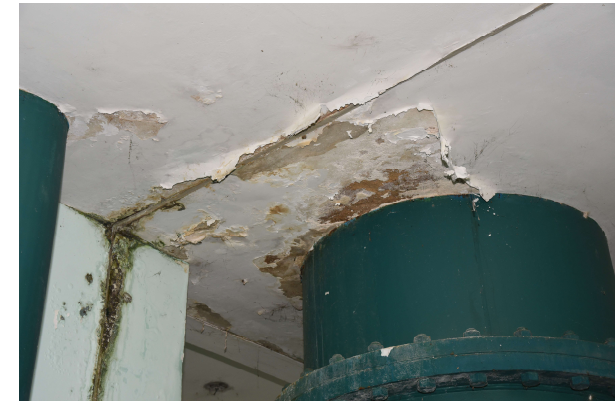
Galeria Longitudinal no nível das Mesas de Comando dos Filtros da VETA
