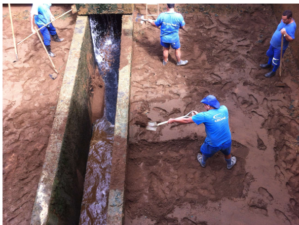
Filtros deteriorados
