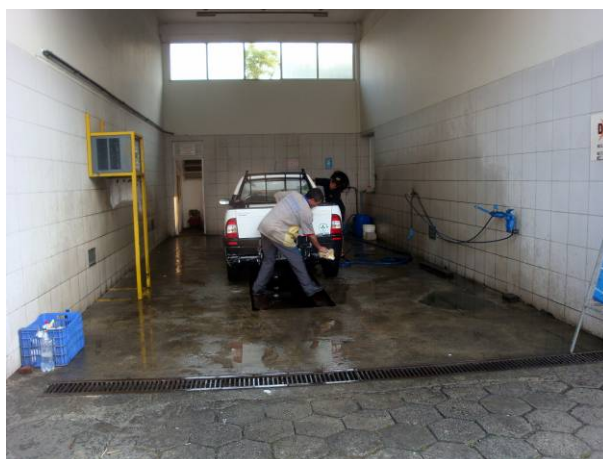
Figura 4 - Área de lavagem de veículos, ausência de canaletas periféricas.
