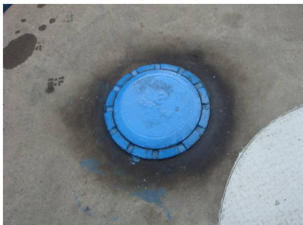
Figura 8 - Sinais de derramamento de diesel ao redor da câmara de descarga selada.
