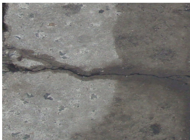
Figura 5 - Piso com leves rachaduras.
