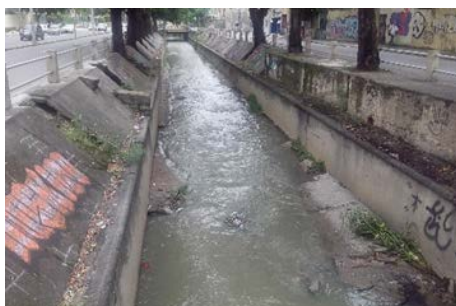
Figuras 1 e 2 – Aspecto característico da presença de esgotos sanitários em rios/canais em áreas urbanas no Rio de Janeiro (Rio Maracanã, Rio Marangá), mesmo em áreas providas de rede, em função da interligação entre os sistemas de esgoto e de drenagem.
