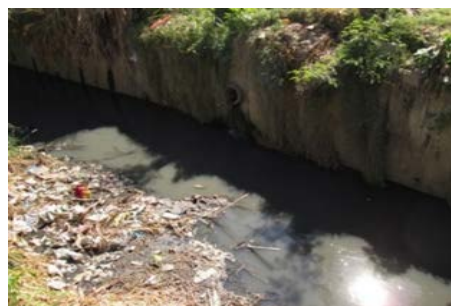
Figuras 1 e 2 – Aspecto característico da presença de esgotos sanitários em rios/canais em áreas urbanas no Rio de Janeiro (Rio Maracanã, Rio Marangá), mesmo em áreas providas de rede, em função da interligação entre os sistemas de esgoto e de drenagem.
