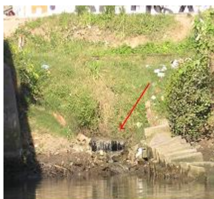
Figura 14. Lançamento de esgoto através de galeria pluvial.
