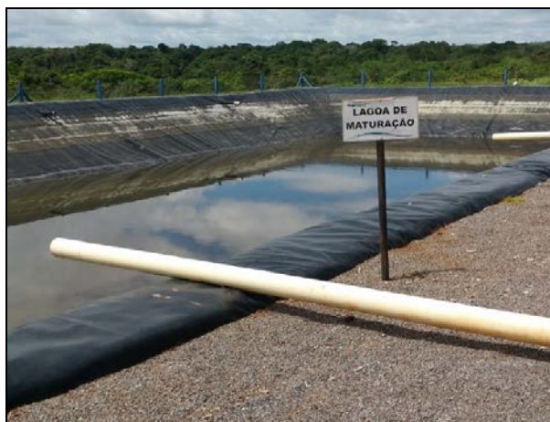
Figura 11 - Lagoa de maturação do aterro sanitário (Fonte: Próprio Autor, 2017).
