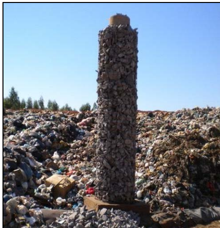
Figura 14 - Sistema de drenagem de gases interligado com o sistema de drenagem de percolado (Fonte: SANORTE, 2014).
