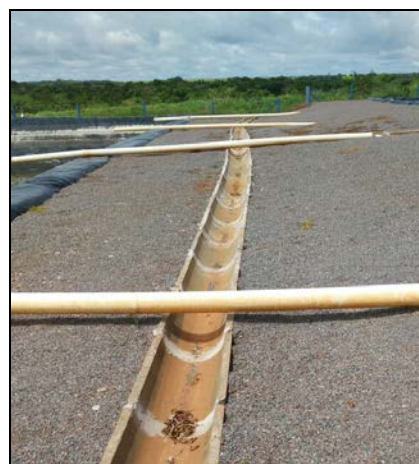
Figura 13 - Sistema definitivo de drenagem de águas pluviais - Canaletas de concreto (Fonte: Próprio Autor, 2017).
