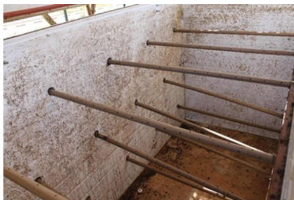
Figura 2: Vista externa e interna dos tubos de aeração
