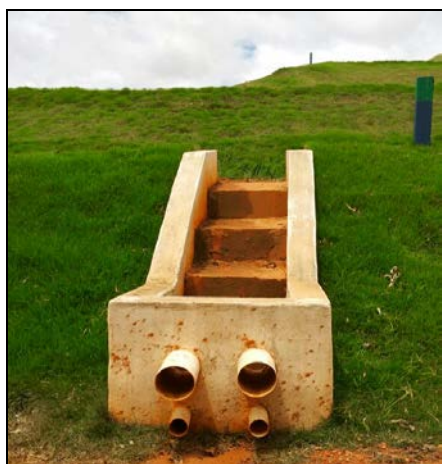
Figura 12- Sistema definitivo de drenagem de águas pluviais - Escada dissipadora (Fonte: Próprio Autor, 2017).
