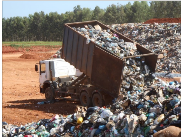
Figura 4 - Frente de trabalho para acesso a caminhões na área de operação do aterro (Fonte: SANORTE, 2014).
