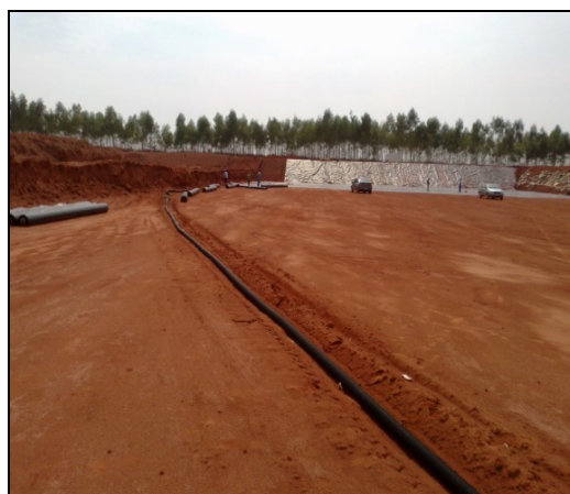
Figura 102 - Dreno Testemunha (Fonte: SANORTE, 2014).
