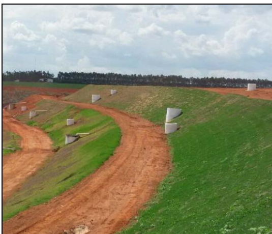
Figura 5 - Dimensões dos Taludes e Bermas no Aterro Sanitário (Fonte: Próprio Autor, 2017).
