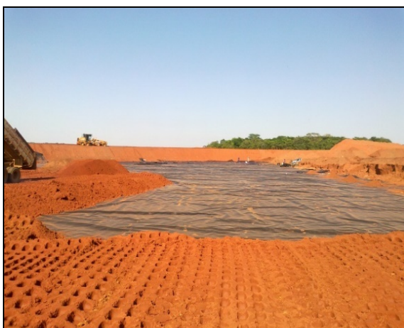
Figura 7 - Sistema de impermeabilização de base (Fonte: SANORTE, 2014).
