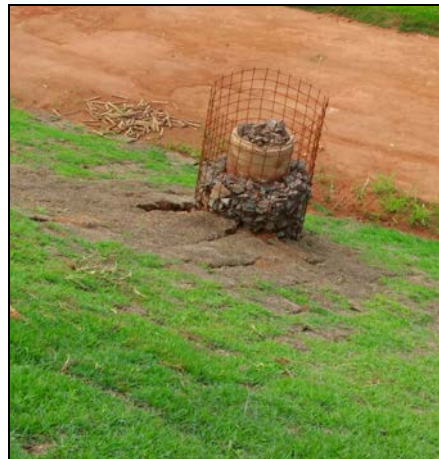
Figura 15 - Dreno de gases em célula já finalizada (Fonte: Próprio Autor, 2017).
