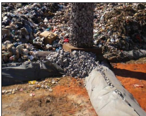
Figura 9 - Sistema de drenagem de percolado interligado ao sistema de drenagem de gases (Fonte: SANORTE, 2014).
