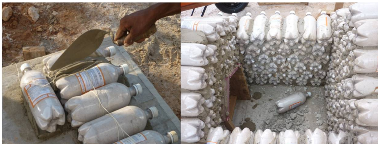
Figura 2 - Posição, amarração e acoplamento das PET's Fonte: Dados da Pesquisa
