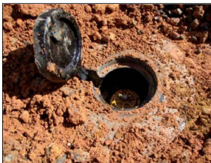
Figura 02. Acabamento do Poço de Monitoramento 04.
