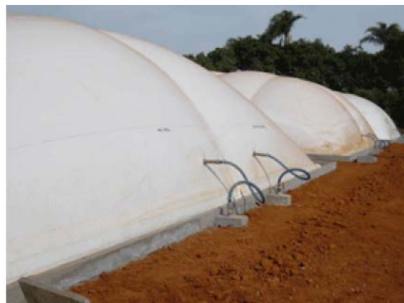
Figura 2: Fotografias de Biodigestores Canadenses. Fonte: WINROCK (2009)
