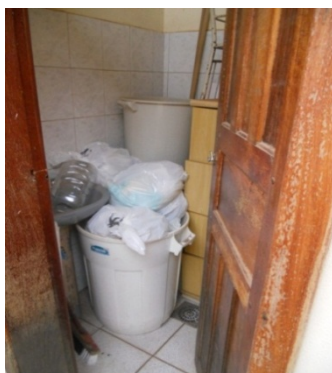
Figura 3: Abrigo reduzido adaptado em um banheiro sem ventilação e identificação na porta – Juatuba.
