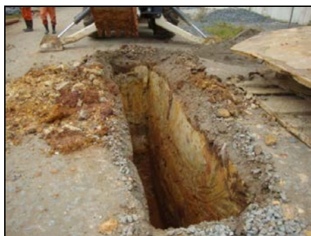
Figura 06. Abertura da Vala de Esgoto.
