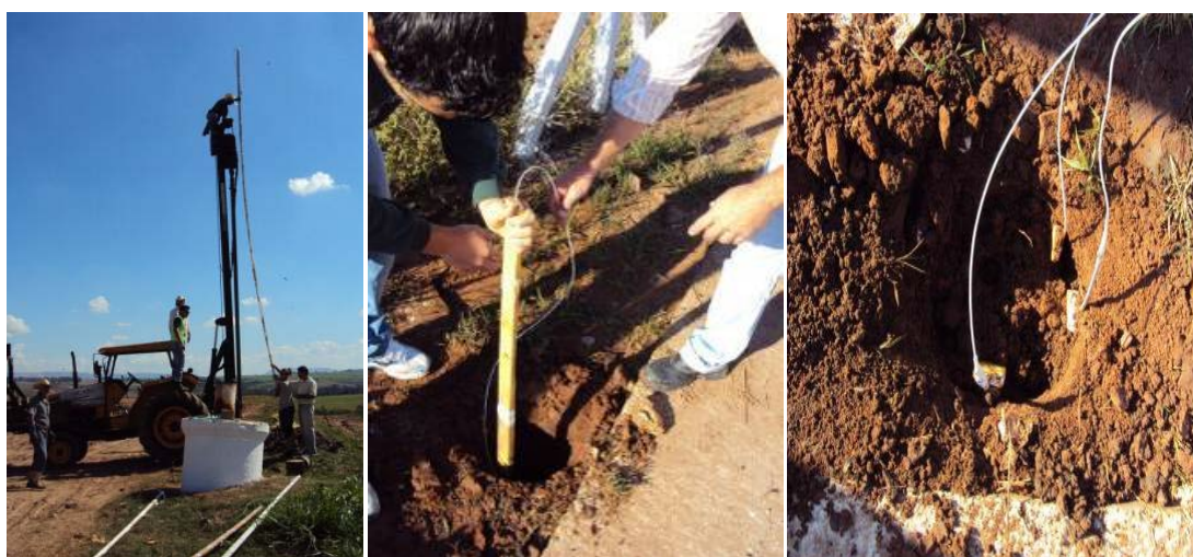
Figura 3- Perfuração da massa de resíduos com trado, posicionamento do conjunto de termoresistência e o conjunto instalados com os cabos.
