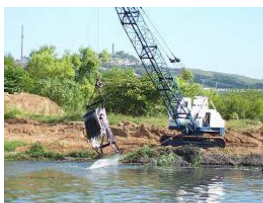
Figura 02: Dragas a serviço do DEP, realizando a dragagem do Arroio Dilúvio. (a) Limpeza do canal, na Av. Ipiranga. (b) Limpeza da foz, na Av. Edvaldo Pereira Paiva.
