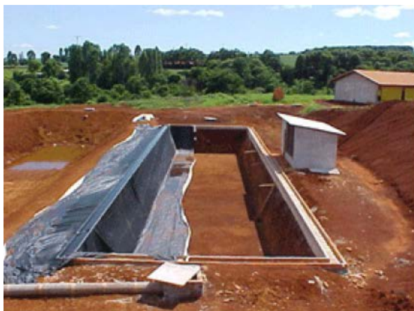
Figura 2: Fotografias de Biodigestores Canadenses. Fonte: WINROCK (2009)
