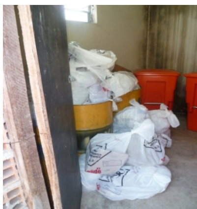
Figura 6: O abrigo não é construído com piso e nem paredes de material liso e impermeável- Pedro Leopoldo.
