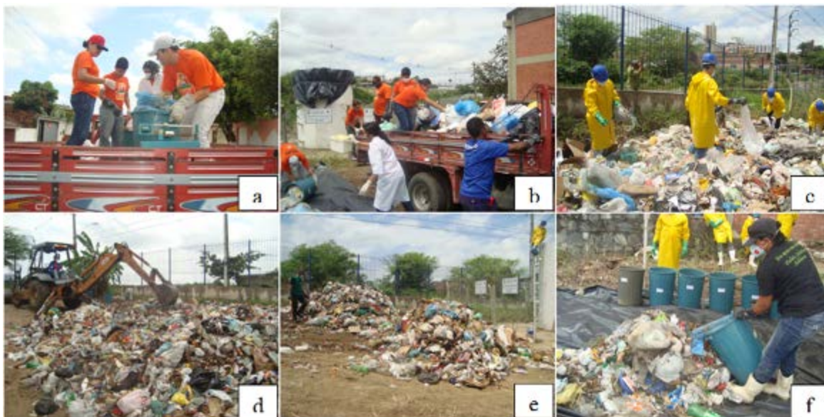
Figura 3: Caracterização dos resíduos (a- pesagem dos resíduos no caminhão; b- descarregamento dos resíduos; c-abertura dos sacos plásticos; d- homogeneização; e- quarteamento; f- separação dos materiais).
