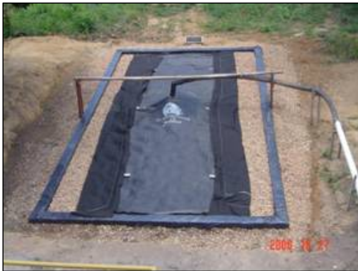
Fig 4. Projeto piloto da tecnologia Geotube na ETA Botafogo
