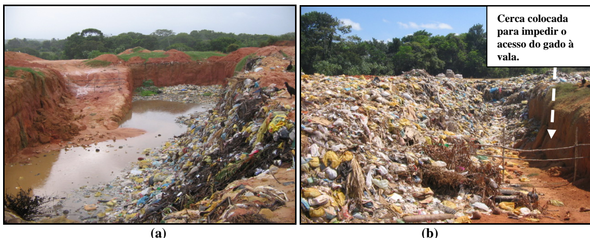
Figura 3 – Aterro Sanitário Simplificado do Município de Saubara: (a) Vala com acúmulo de água, maio de 2007; (b) Mesma vala com disposição inadequada, novembro de 2007.
