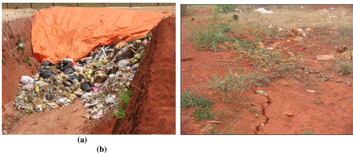
Figura 4 – Aterro Sanitário Simplificado do Município de Aporá, Bahia: (a) Vala coberta temporariamente com lona plástica, porém com comprimento inferior ao necessário – Outubro de 2005; (b) Surgimento de fissuras na vala.
