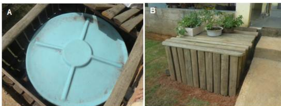
Figura 2: (A) Vista da unidade de biofiltro dentro da estrutura de madeira. (B) Vista da unidade de biofiltro encoberta pela estrutura de madeira.
