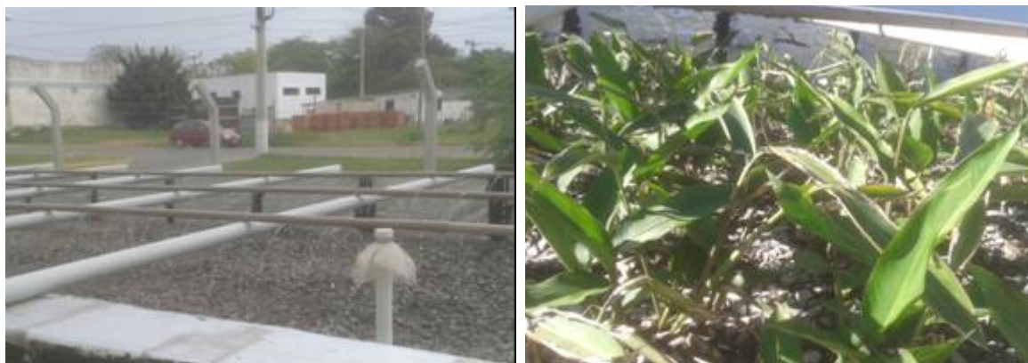
Figura 2: Condições em que foram realizados os testes hidrodinâmicos no WCFV. À esquerda, fotografia do WCFV antes do transplântio e à direita, fotografia mostrando o WCFV 93 dias após o transplântio de Heliconia psittacorum
