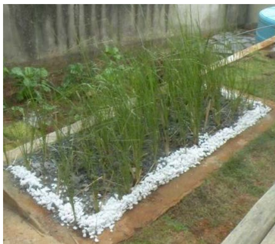
Figura 3: Sistema de tratamento wetland de fluxo horizontal e escoamento subsuperficial.
