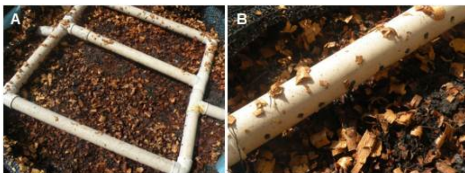
Figura 1: (A) Sistema de dispersão da água cinza sobre a superfície do biofiltro. (B) Detalhe do sistema dosador de fluxo.
