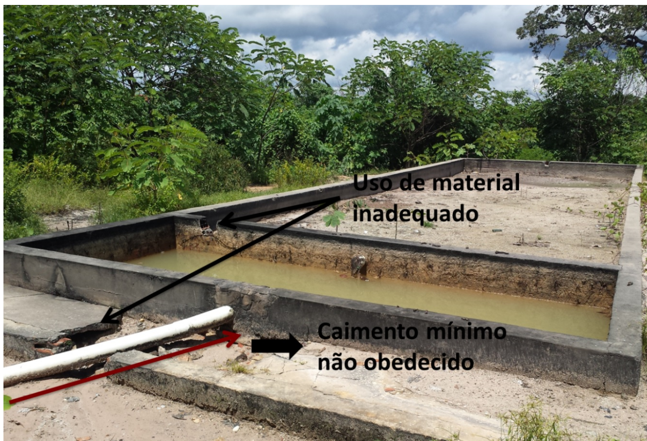
Figura 5: Tanque de zona de raízes com detalhamento de erros construtivos identificados. Fonte: Elaborado pelo autor.
