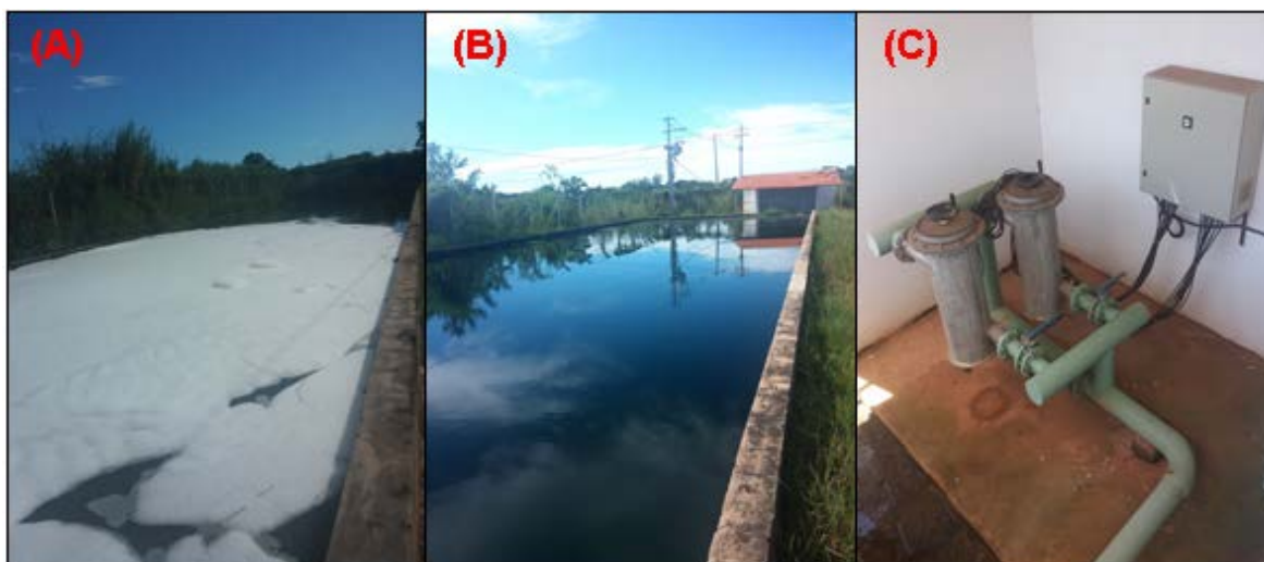
Figura 4 – Unidades do Tratamento Terciário. (A) Tanque de Plantas Aquáticas Flutuantes. (B) Tanque de Plantas Aquáticas em Leito Fixo. (C) Unidade de Desinfecção por Radiação Ultravioleta.
