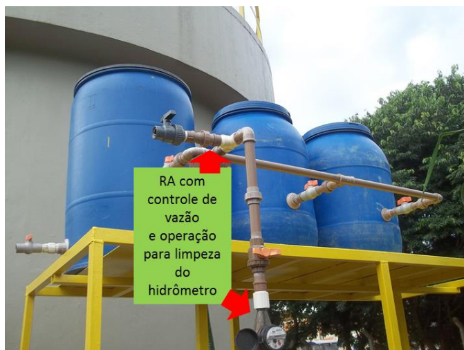
Figura 7. Detalhe do sistema de RA interligado para alimentação das unidades MA e WCs.
