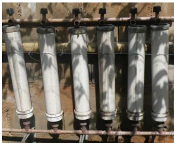
Figura 4: Sistema de filtros de carvão ativado.
