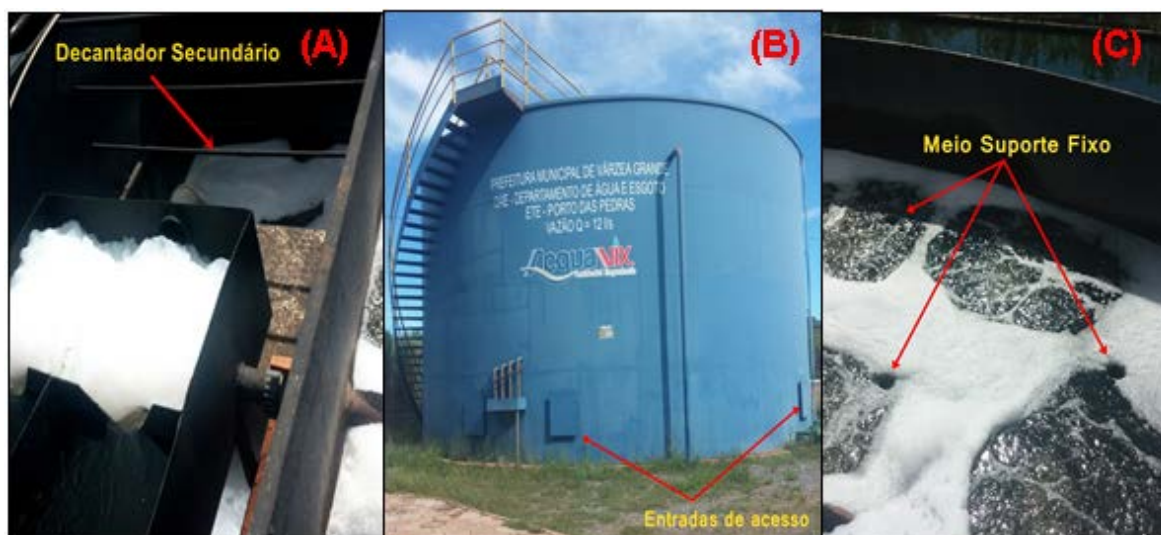
Figura 3 - Unidades do Tratamento Secundário. (A) Decantador Secundário. (B) Unidade Compacta com indicação das entradas de acesso da mesma. (C) Indicação do Meio Suporte Fixo no FBASN.
