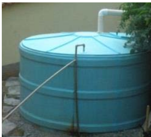
Figura 5: Reservatório hermético para armazenamento de águas cinza tratada.
