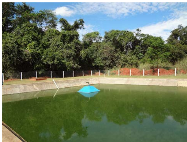
Figura 1: Lagoa facultativa com UASB incorporado – ETE Embrapa Arroz e Feijão.
