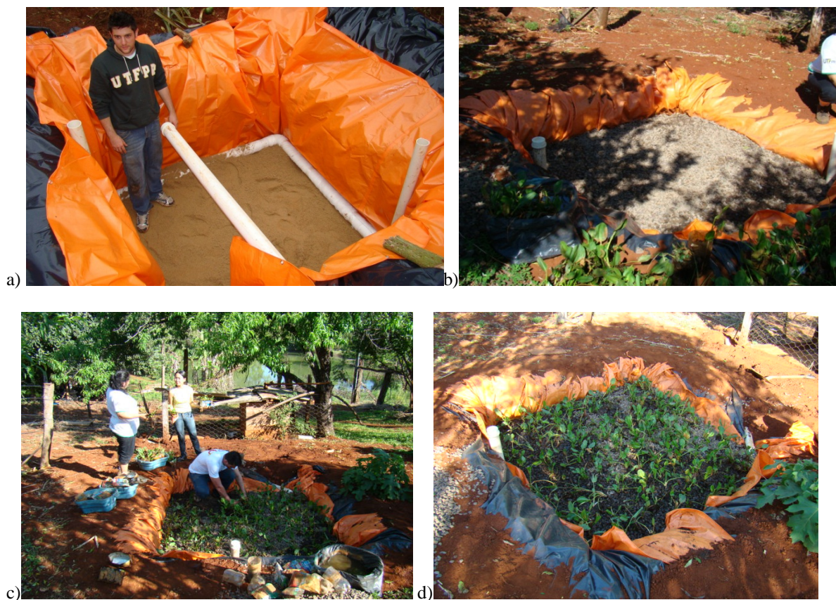
Figura 1. Montagem da estação de fitotratamento a) impermeabilização e colocação da tubulação, b) Colocação da brita, c) Plantio das mudas e d) estação finalizada.
