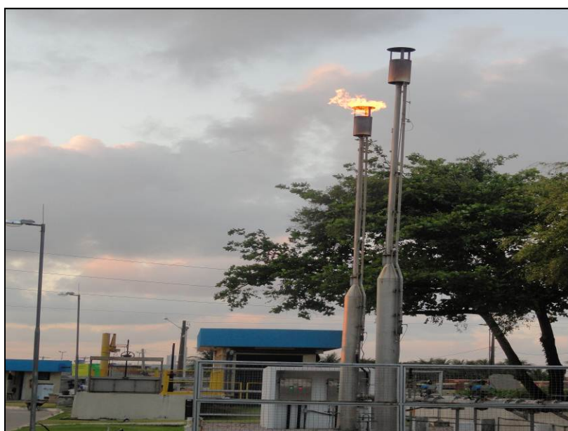
Figura 1: Queimadores de biogás da ETE do Baldo em operação
