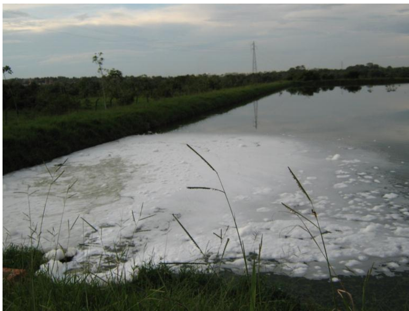
Figura 5 - Lagoa de maturação (a jusante da lagoa facultativa) e a presença de escumas/espumas. Cacoal, Rondônia, janeiro de 2011.
