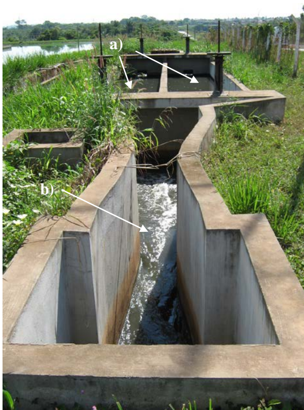
Figura 2. Sistema preliminar de tratamento, Cacoal, Rondônia, maio de 2010. Em que, a) caixa de areia e b) Calha parshall.
