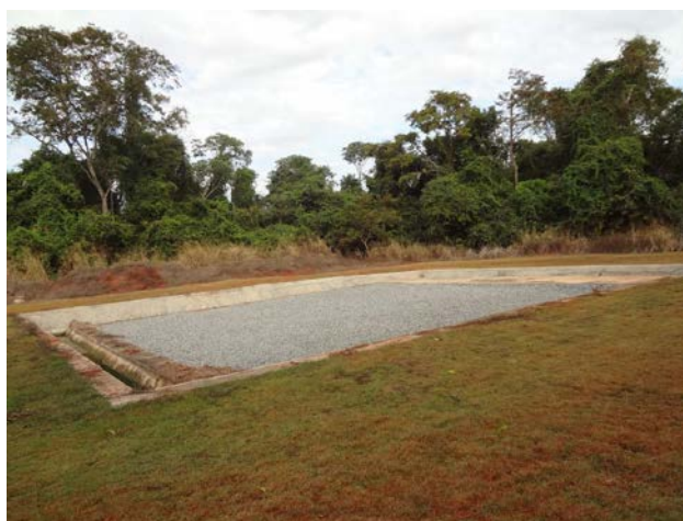
Figura 2: Banhado artificial (wetland) – ETE Embrapa Arroz e Feijão.
