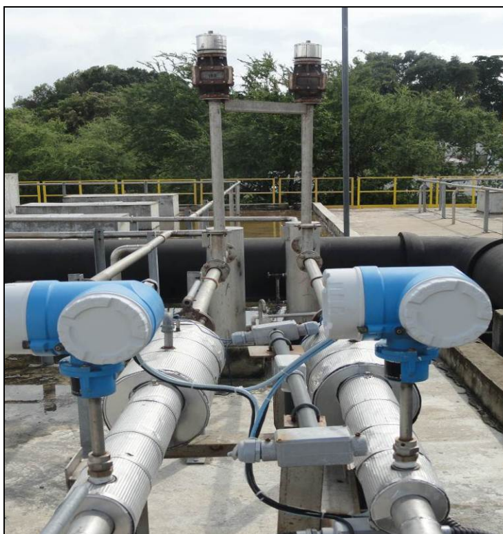
Figura 2: Sistema de coleta de biogás da ETE do Baldo, vendo-se em primeiro plano os medidores de vazão dos gases e em segundo plano a válvula corta-chama.
