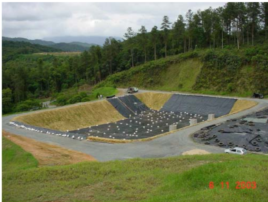
Figura 2 – Vista da segunda trincheira sendo impermeabilizada.
