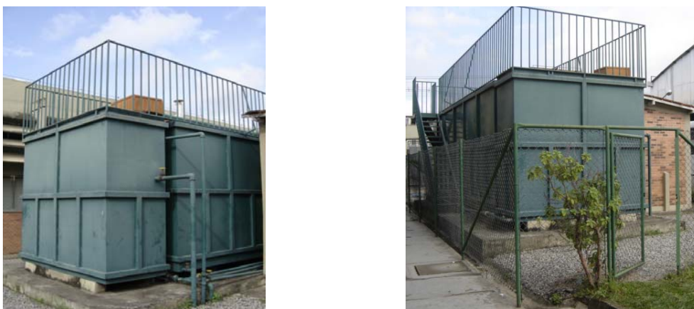
Figura 01: ETE- LODO ATIVADO POR AERAÇÃO PROLONGADA
