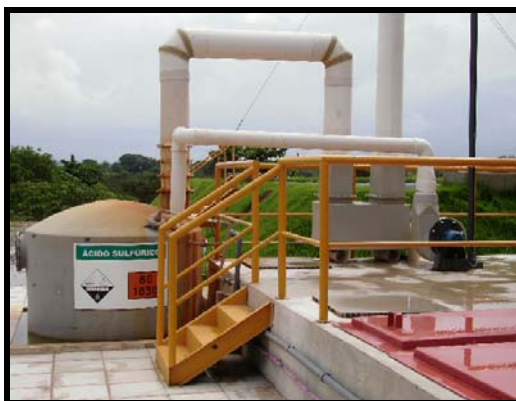
Figura 4: Lavador de gases para absorção de amônia.
