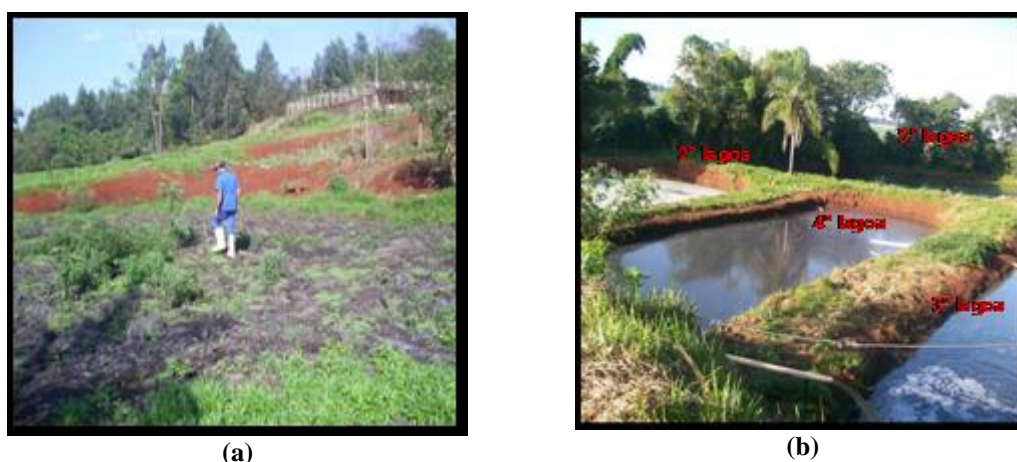
Figura 2. Vista da primeira lagoa do sistema de tratamento de efluente (a), e vista parcial das unidades que compõem o sistema de tratamento de efluentes do Frigorífico.
