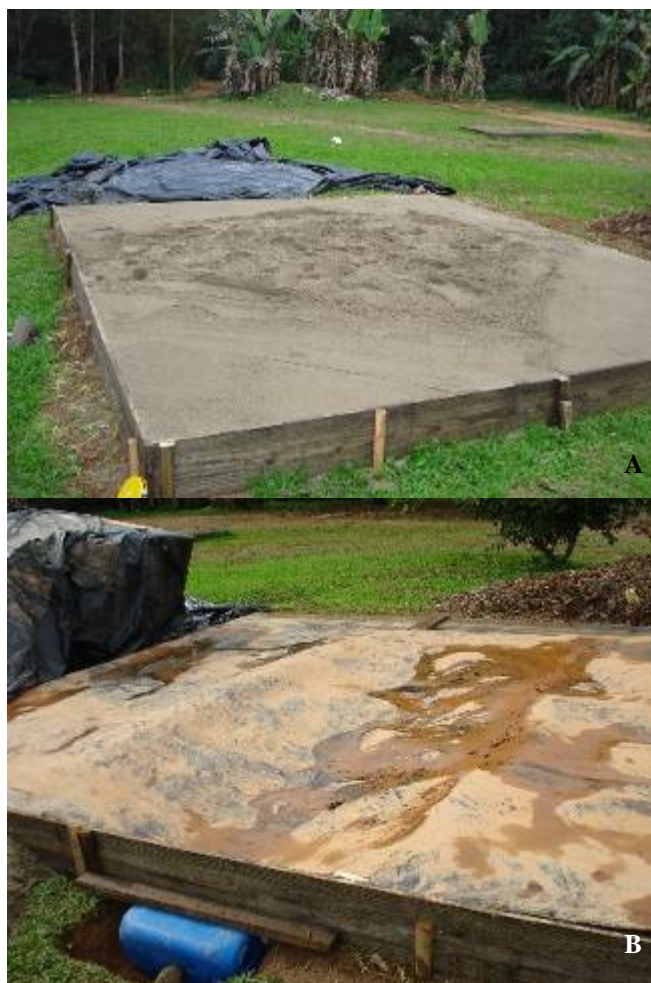
Figura 1. Preparo inicial do solo. A) Nivelamento; B) Impermeabilização com Geomembrana e Drenagem do chorume.
