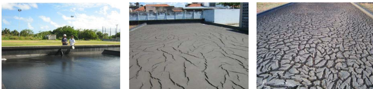
Figura 03: processo de desidratação por exposição solar do lodo em leito de secagem na ETE Cabanga.
