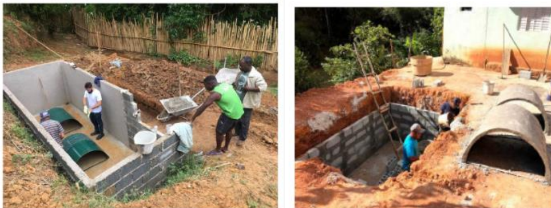
Figura 4: Exemplos da execução dos TEvap: levantamento das paredes de alvenaria, disposição das formas no interior do tanque para a confecção das peças da câmara de digestão em argamassa armada (esquerda) e peças em argamassa armada pré-confeccionadas prestes a serem instaladas no tanque (direita).
