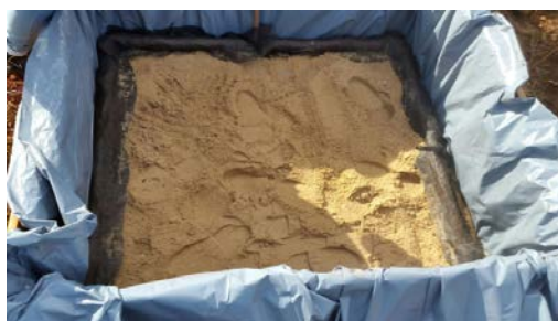
Figura 5 - Camada de areia com a tela protetora na tubulação
