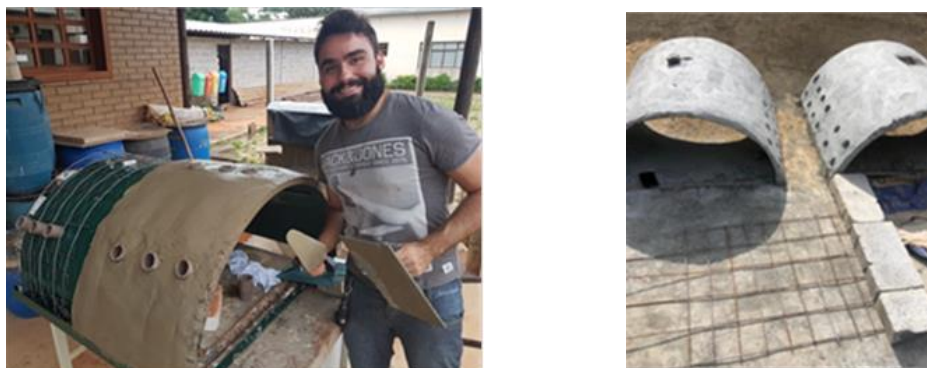
Figura 9: Ilustração da execução (esquerda) e peças prontas (direita) dos painéis de argamassa para a câmara de digestão dos TEvap.
