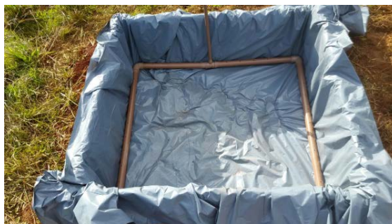
Figura 4 - Instalação da tubulação de coleta do efluente
