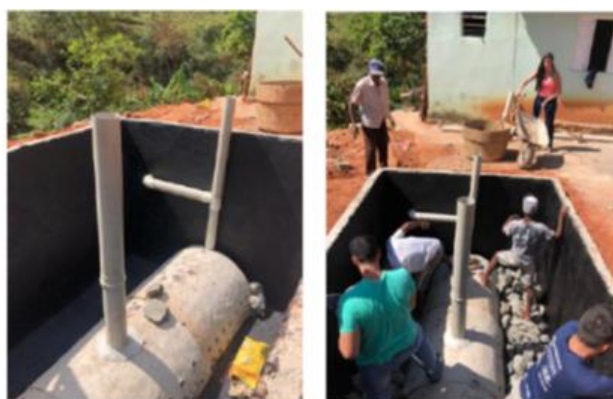
Figura 10: TEvap em construção: composição da câmara de recepção / digestão com peças de argamassa armada, posicionamento de tubulações de inspeção e limpeza e preenchimento lateral com pedras de mão.
