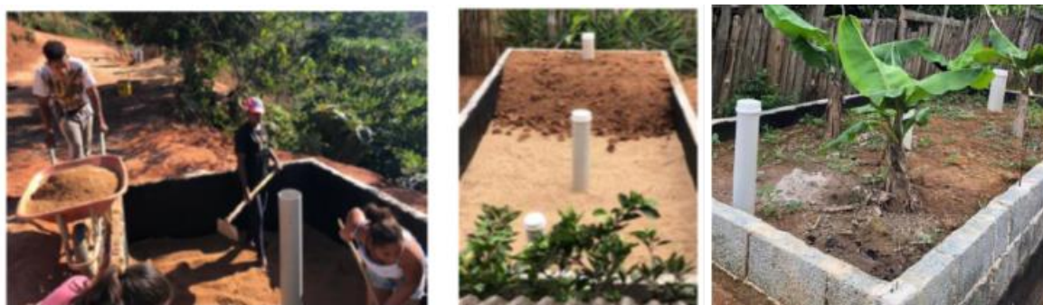
Figura 5: Preenchimento do TEvap (esquerda e centro) e solução final com plantio de mudas de bananeira (direita)
