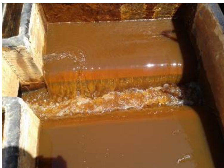
Figura 2 – Retrolavagem do filtro de fluxo descendente.
