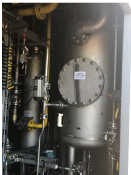
Figura 4- Sistema de remoção de H 2 S e de pressurização e ao lado unidade de resfriamento.
