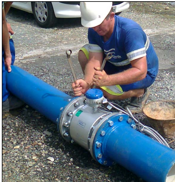
Figura 09: Macro medidor a ser instalado na entrada do DMC
