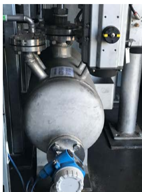
Figura 4- Sistema de remoção de H 2 S e de pressurização e ao lado unidade de resfriamento.
