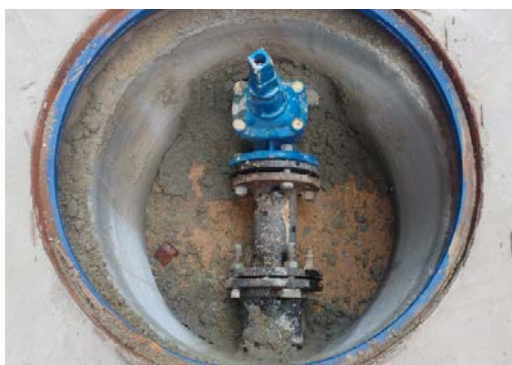
Figura 5 – Placa de Orifício instalada dentro do Poço de Visita (PV).
