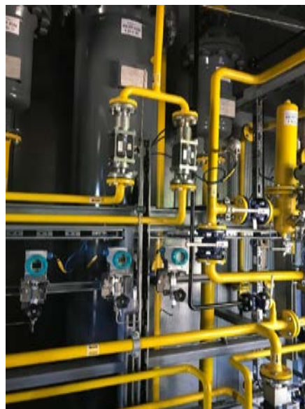
Figura 3 – Ilustração do interior do contêiner, com pré-filtro e coluna de PSA, na figura da direita.
