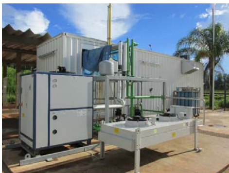
Figura 5 - Trocador de calor e ao lado chaminé de saída do gás de escape (gás fraco).
