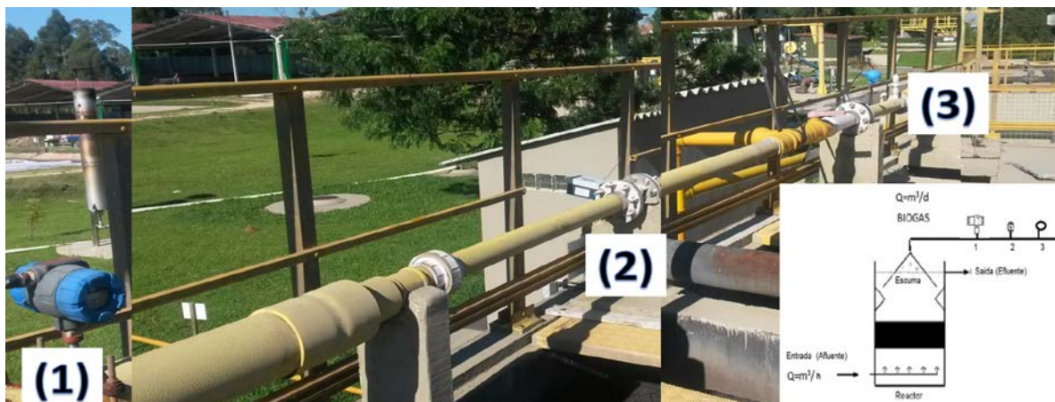
Figura 1 – Reator UASB: Instrumentação na linha de biogás.
