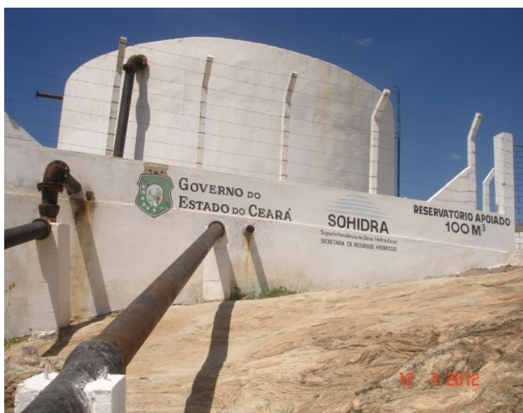
Figura 3: Reservatório de distribuição.
