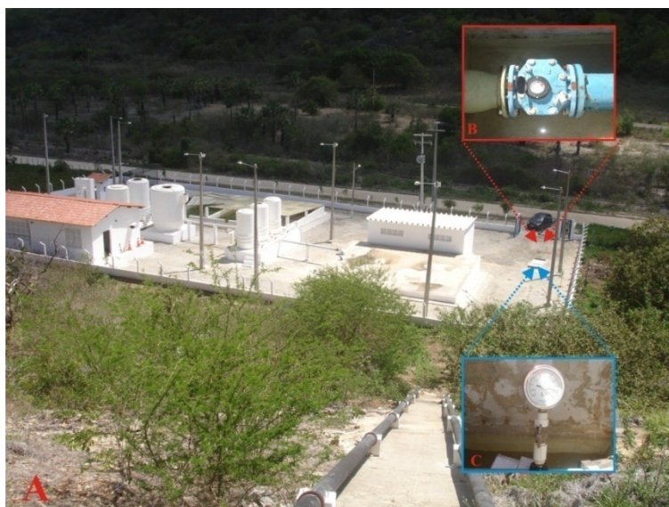
Figura 5: Estação de tratamento de água, macromedidor e manômetro analógico.
