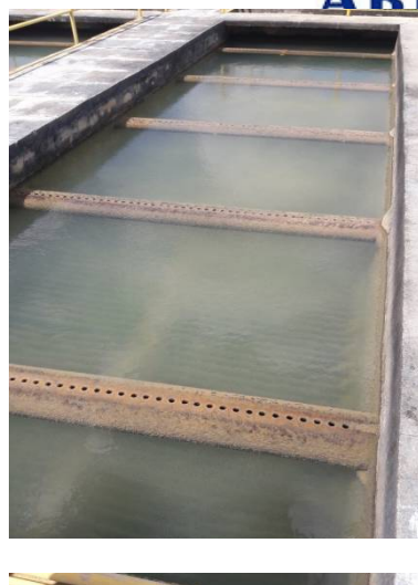
Figura 3 – Fotografia do Decantador da Oviêdo Teixeira.
