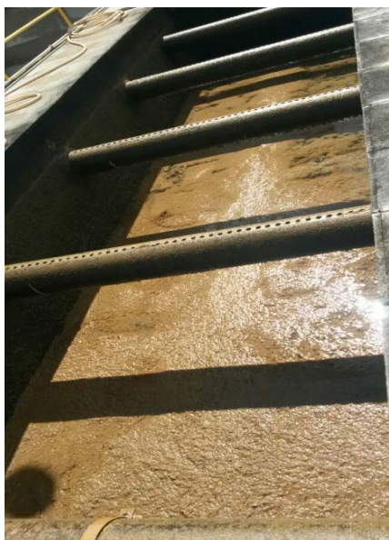
Figura 4 - Decantador em descarga de lodo.
