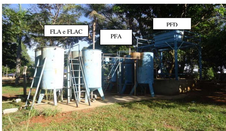
Figura 2: Instalação piloto de Filtração em Múltiplas Etapas
