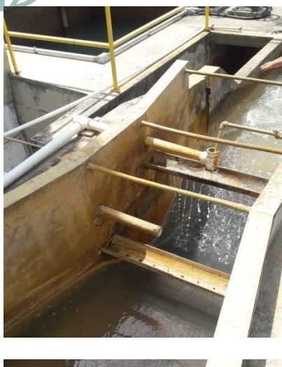
Figura 2 – Calha de distribuição do coagulante na água bruta.
