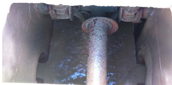
Figura 5 - Tubulação de descarga do lodo.
