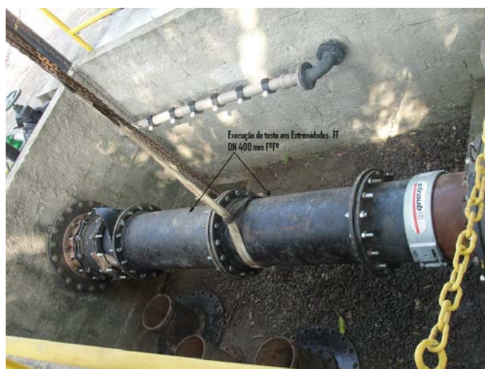
Figura 4. Teste em extremidade FF DN 400mm Ferro Fundido
