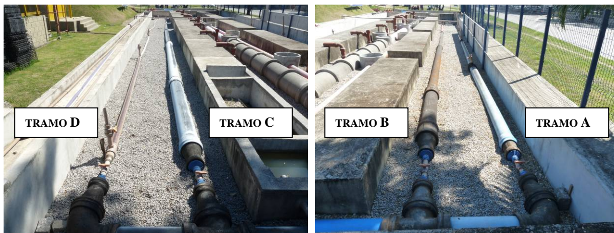
Figura 5: Derivação dos 4 tramos da rede de distribuição
