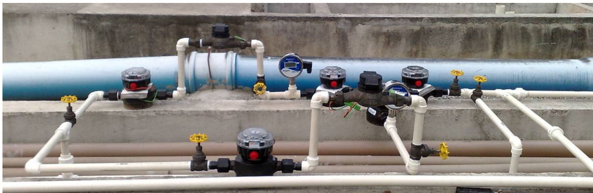
Figura 7: Cavaletes de micromedicação predial
