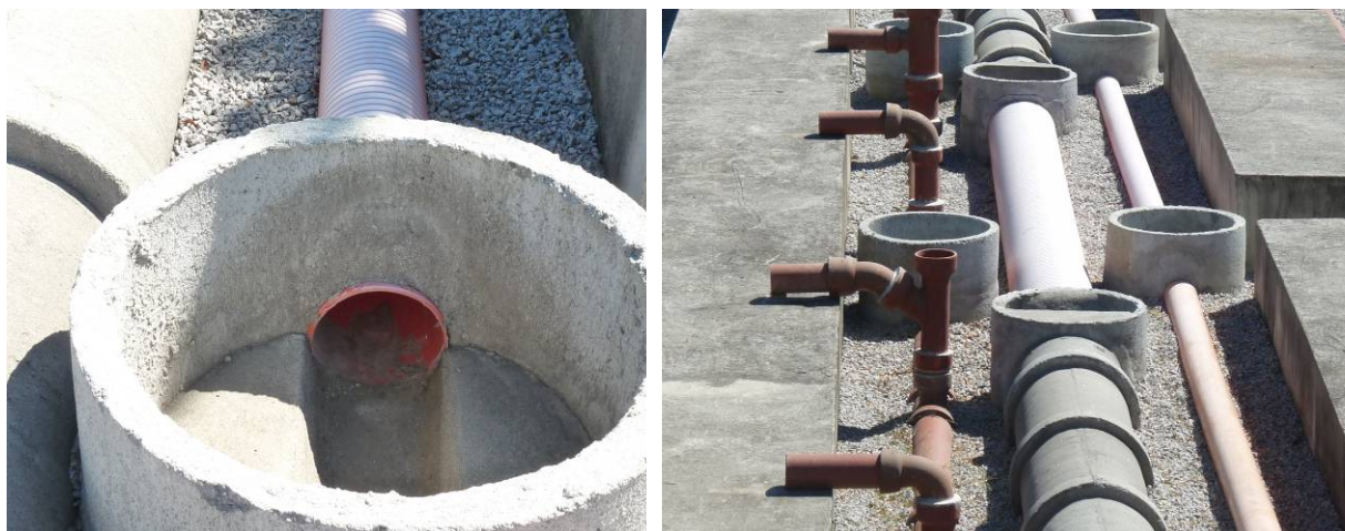
Figura 10: Singularidades de inspeção da rede coletora de esgotos
