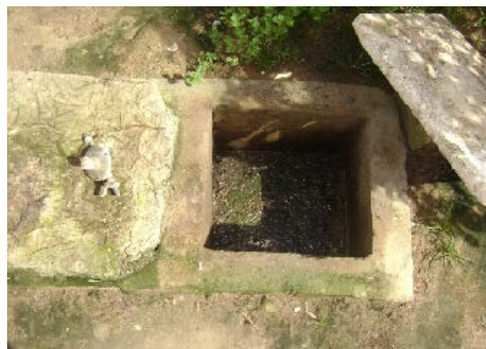
Figura 3: Caixa de gordura sem tampa
