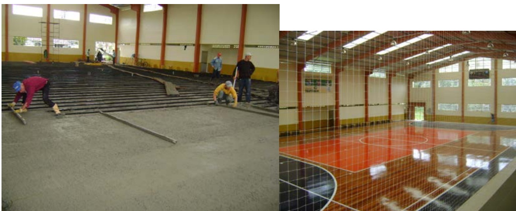
Uso de resíduos sintéticos como brita leve na construção civil e em ginásios para absorção de impactos
