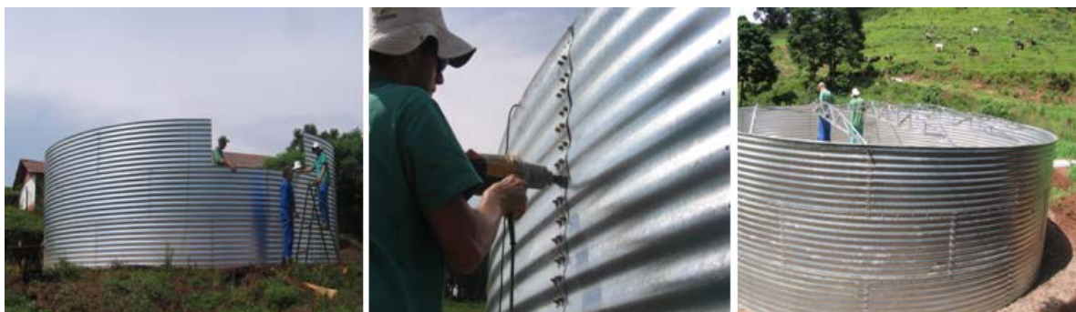
Figura 3: Etapas de construção do reservatório de chapas de aço galvanizado.
