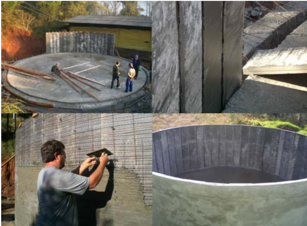
Figura 1: Etapas de construção do reservatório de ardósia.
