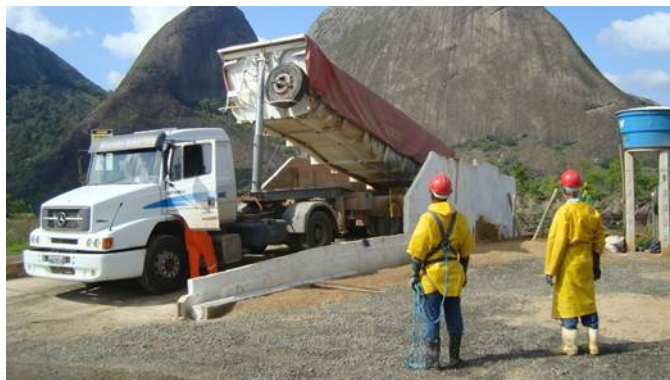
Figura 7: Caminhão sendo basculado para deposição de resíduos no interior da célula.
