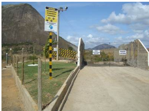
Figura 6: Acesso à rampa de descarregamento de resíduos, situada na parte superior da célula. Detalhe das sinalizações referentes à segurança para a realização dos serviços.
