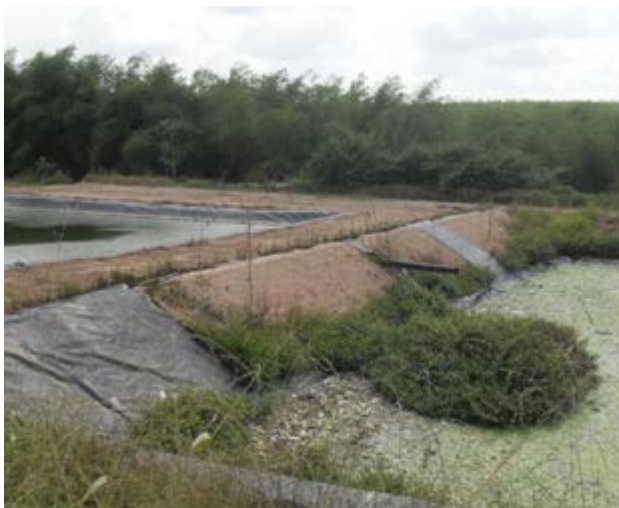
Figura 4: Mantas das lagoas para o tratamento de chorume danificadas
