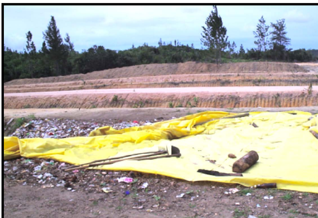
Figura 3 – Utilização de manta de sacrifício no Aterro Simplificado de Baixo/Palame (Bahia)
