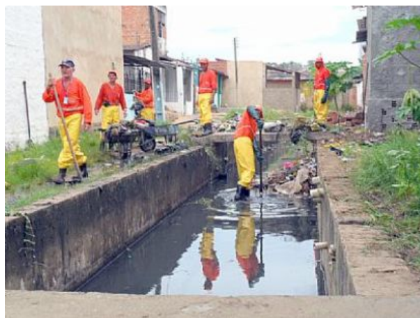
Figura 3: Obstrução de córregos causada pela disposição incorreta de RCC em Maceió.
