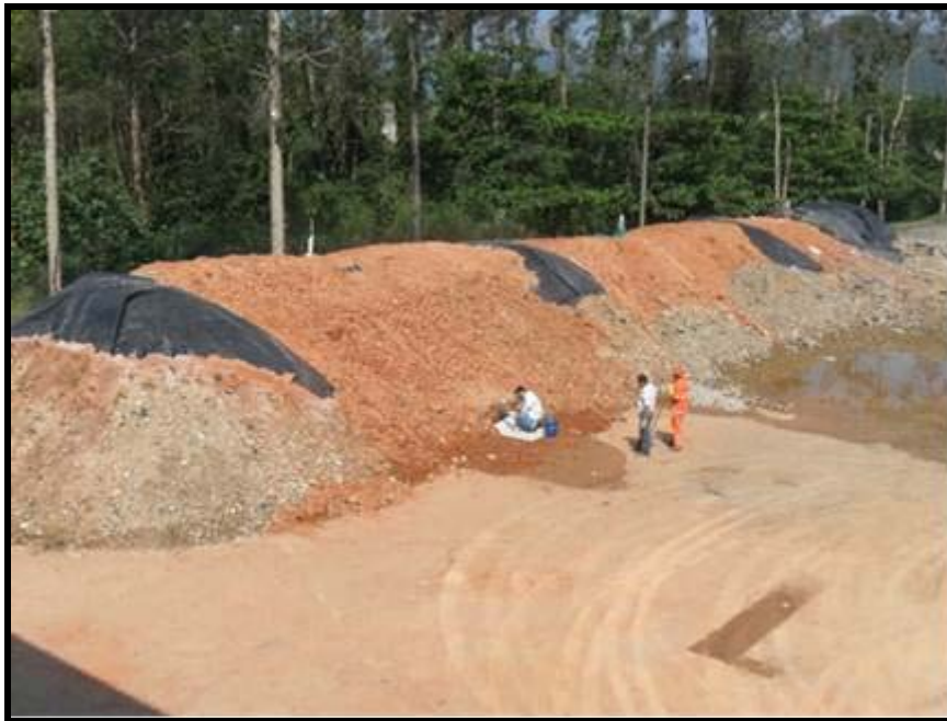
Figura 2 – Panorâmica das células após finalização da cobertura com solo argiloso.
