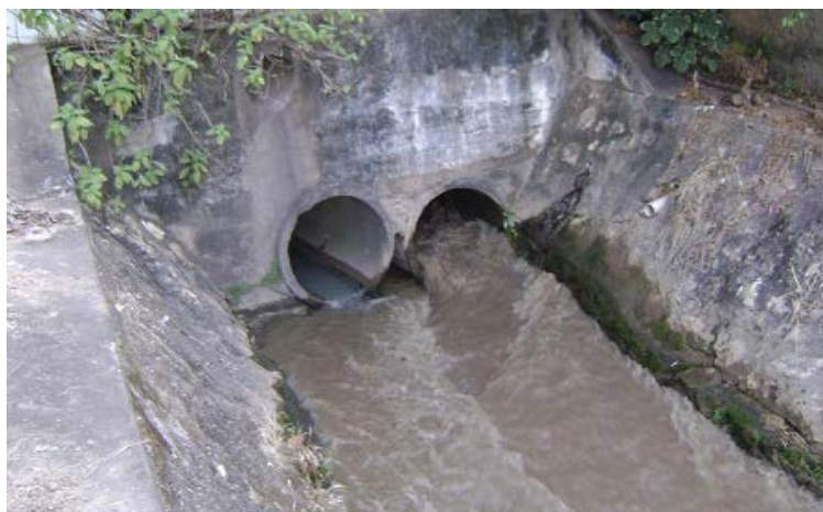
Figura 2: Despejo da ETA e de esgoto no Córrego Mãe Bonifácia.
