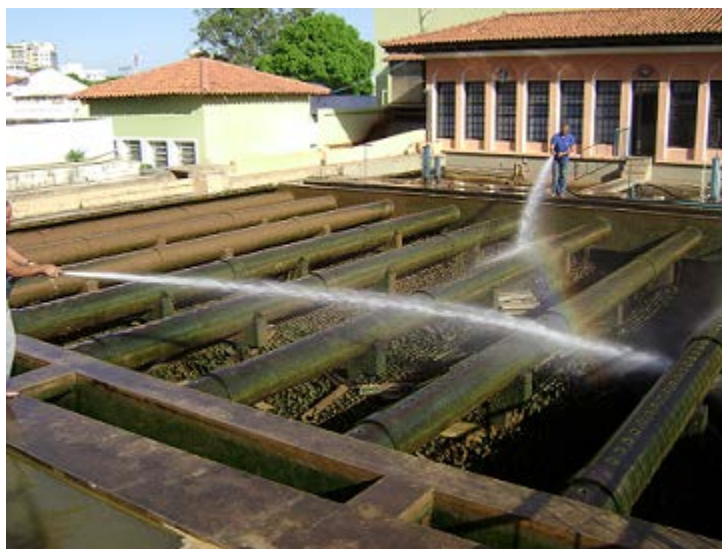
Figura 1: Lavagem pressurizada do decantador da ETA II São Sebastião.
