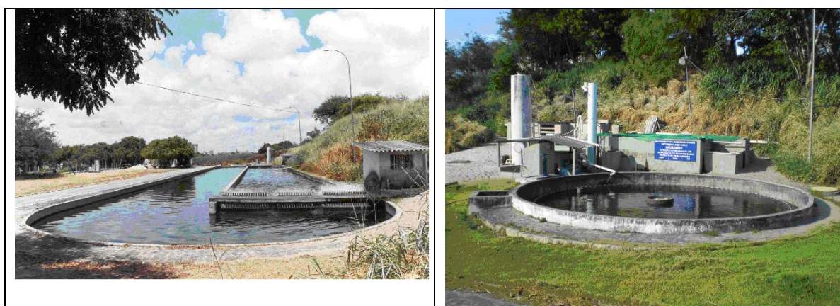
Figura 03: a) Valo de Oxidação ; b) Decantador Secundário da ETE/UFRN. Fonte: (BEZERRA, 2004)
