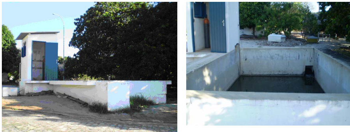
Figura 04: a) Abrigo dos cilindros de cloro; b) Tanque de contato recebendo o efluente para desinfecção
