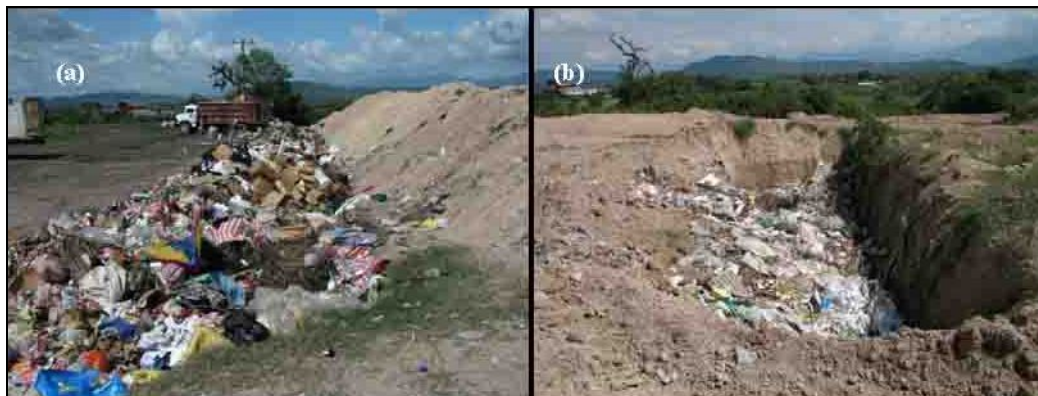
Figura 4: a) A trincheira cheia foi deixada aberta por três a quatro semanas para permitir a compactação natural devido à decomposição e sedimentação por compressão e separação natural dos sólidos (pequenas partículas migram através dos espaços vazios). b) A trincheira foi preenchida e deixada por três semanas, resultando em ganho de aproximadamente 30 a 40% do volume devido à compactação natural.
