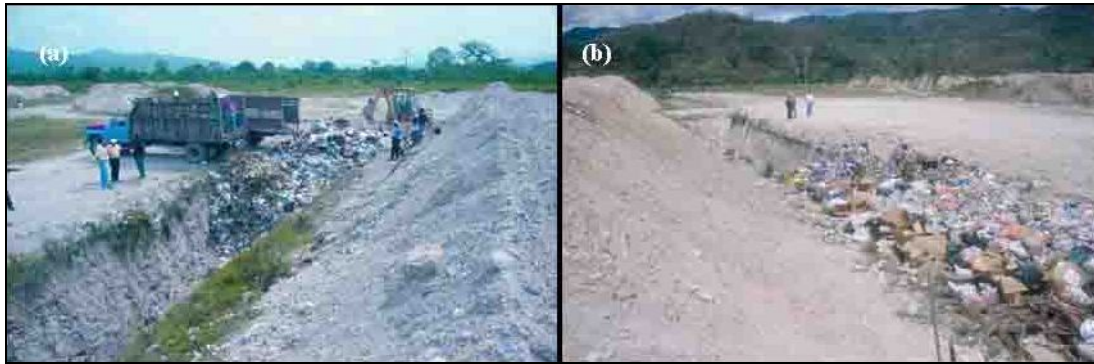
Figura 3: a) Os resíduos foram despejados na vala com inclinação controlada para formar a célula diária, que tem um volume e superfície mínimos. Observe o material excedente da escavação da trincheira. b) Um mínimo de área superficial foi exposta, pois a trincheira foi preenchida ao longo de seu comprimento, em células diárias.
