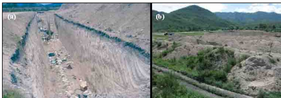
Figura 2: a) As paredes verticais da trincheira (5m x 5m x 60m) foram escavadas com uma escavadeira de médio porte (138CV, 1\text{m}^3 caçamba) em 36 horas e tiveram duração de três semanas a um mês até ser preenchida. O metano foi gerenciado com chaminés construídas com pedras rochosas. b) Superávit do solo das escavações de trincheiras pôde ser armazenado e valorizado para uso local ou externo.
