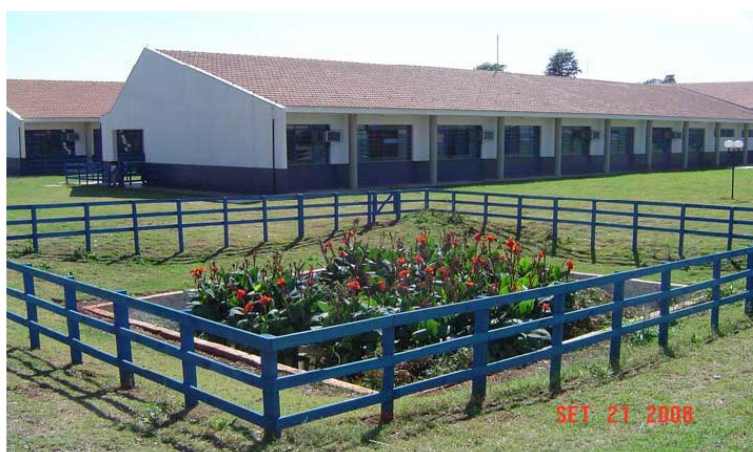
Figura 3 – Wetland de fluxo vertical (zona de raízes) implantada na Escola Municipal Padre Luigi Salvucci, Foz do Iguaçu, Paraná. Fonte: Projeto Vida à Água (2010)
