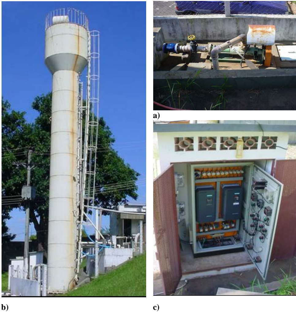
Figura 1-Fotos do Reator Anaeróbio de Leito Expandido utilizado.
