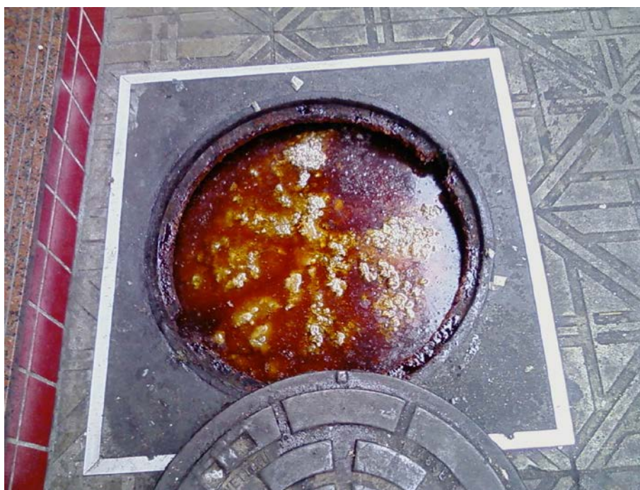
Figura 3: Gordura despejada na Caixa de Inspeção.
