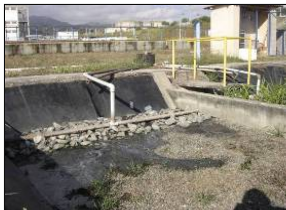
Figura 4: Imagens do escoamento superficial indesejado na wetland plantada, após poda recente, e na wetland não plantada
