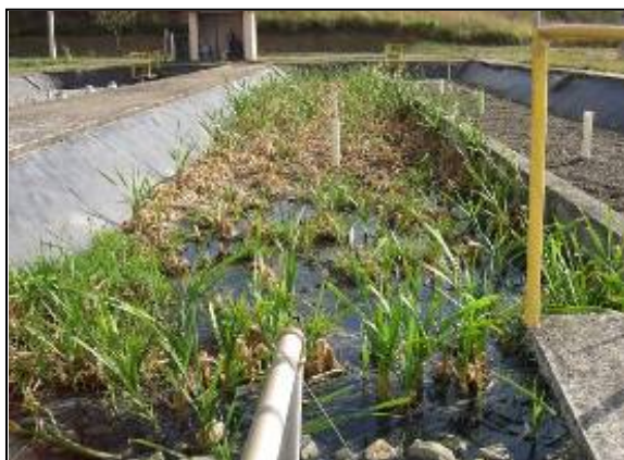
Figura 4: Imagens do escoamento superficial indesejado na wetland plantada, após poda recente, e na wetland não plantada
