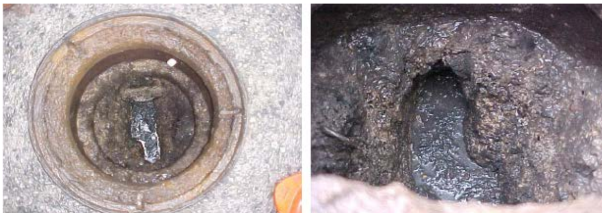
Figura 7 – Placa de gordura retirada da rede coletora de esgoto
