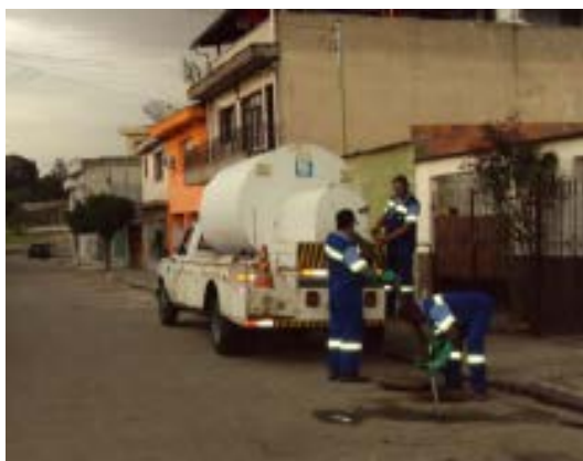
Figura 3 – Serviço de desobstrução de rede coletora de esgoto
