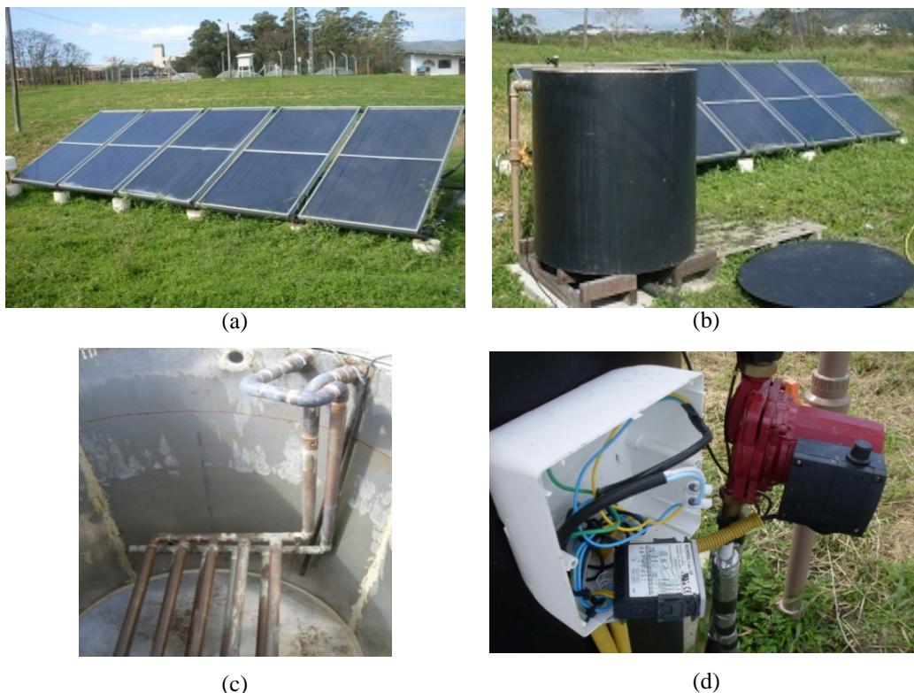
Figura 02: (a) Coletores solares planos; (b) reator de desinfecção de lodo; (c) trocador de calor; (d) controlador e bomba automática de circulação de água.
