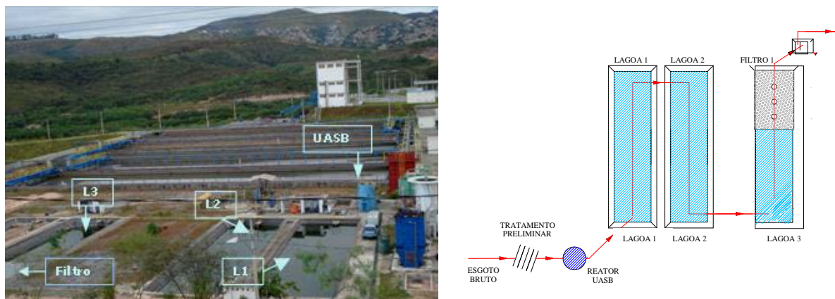
Figura 1 - Fluxograma e vista parcial do aparato experimental: UASB, Lagoas 1, 2, 3 e Filtro
