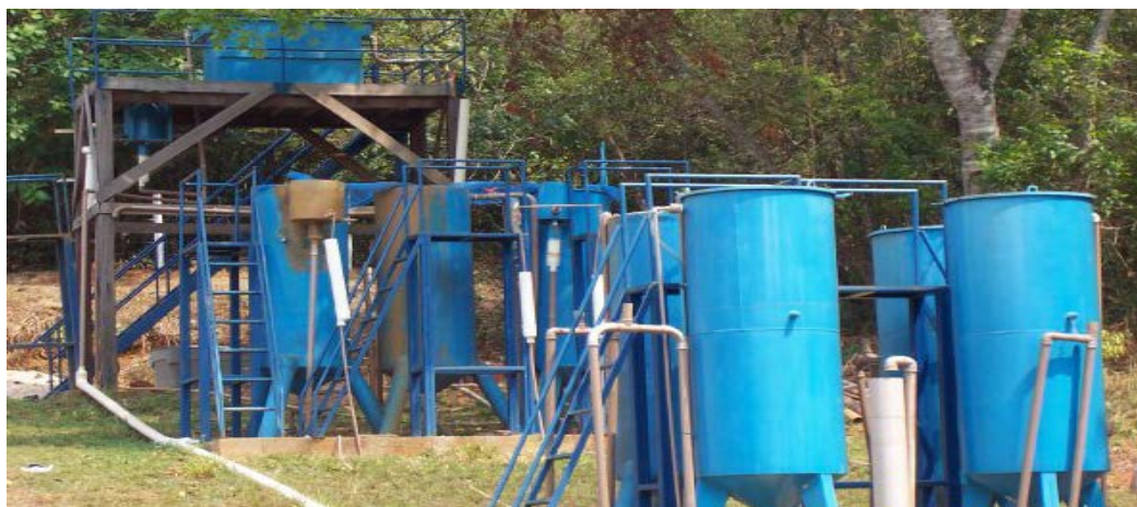
Figura 1. Instalação piloto da FIME na ETA de Goianápolis.
