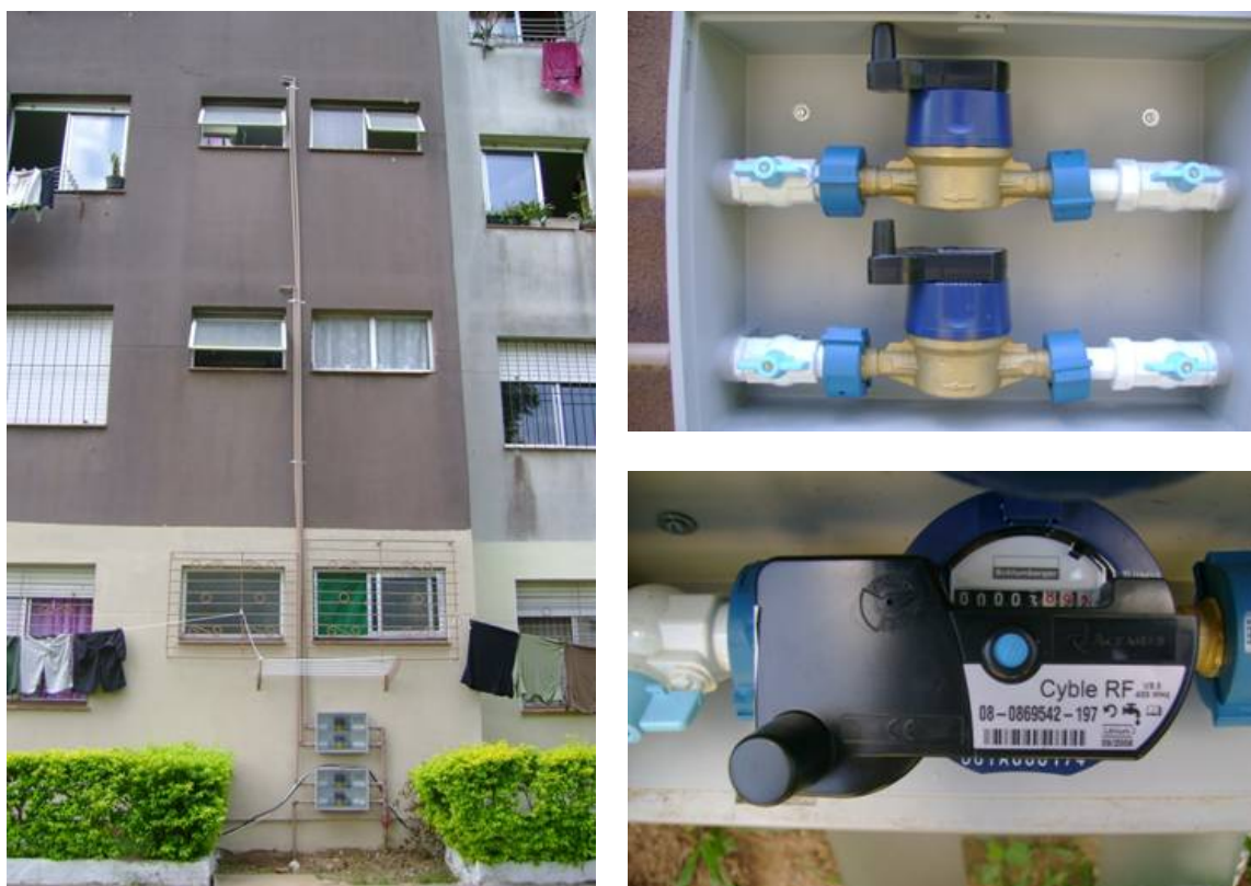
Figura 3: Detalhes da instalação dos medidores e sensores.
