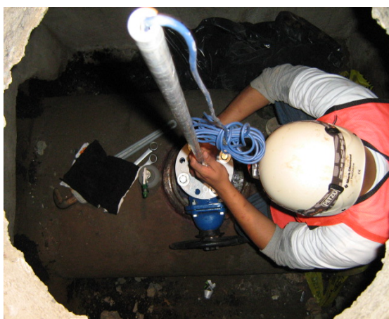
Figura 4: Início de inserção do sensor
