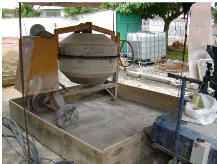
Fig. 02: Prática correta – mistura de concreto com base de apoio.
