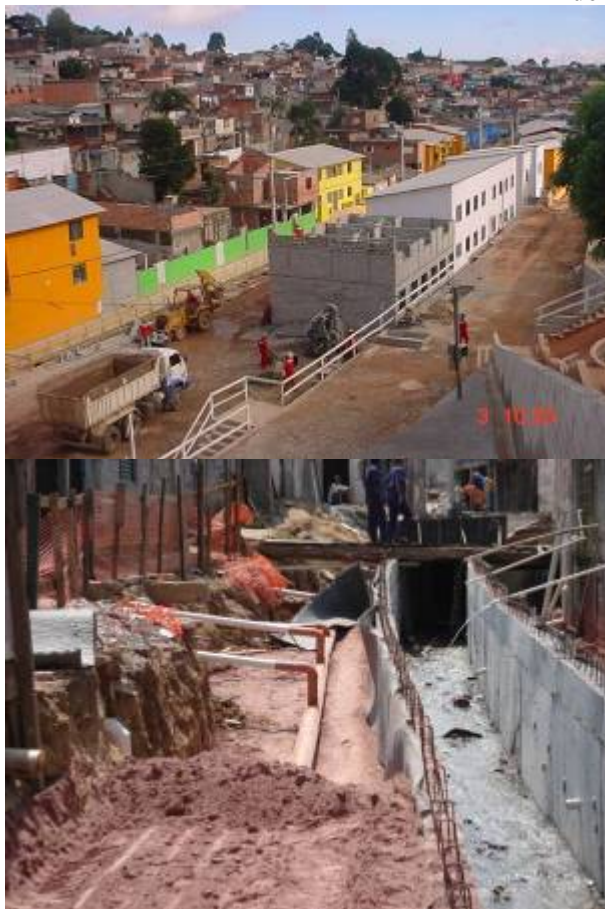
Figura 5: Implantação das Redes Coletoras de Esgotos
