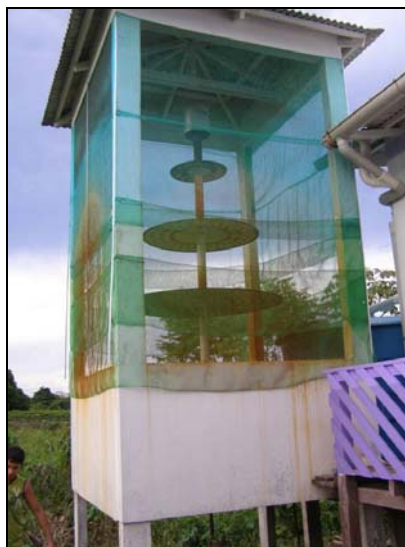
Figura 2 – Foto do sistema de aeração com o tanque de armazenamento na parte inferior.
