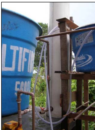
Figura 3 – Foto do sistema de filtração durante o processo de implantação.
