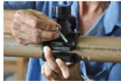
Colocar os parafusos.
