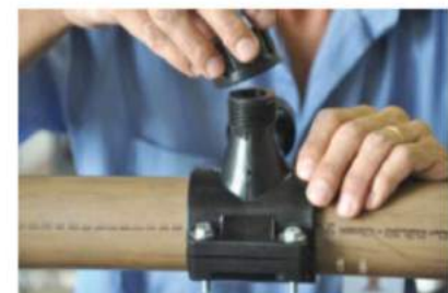
Recolocar a tampa do colar, sem aperto.
