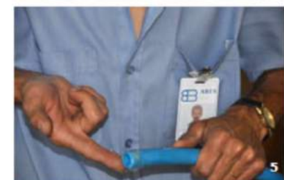
Lubrificar a ponta do tubo.
