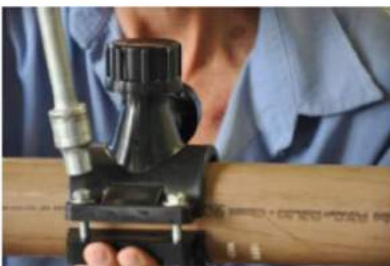
Apertar os parafusos com a chave multifunção
