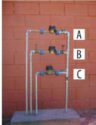
Figura G.1 – Montagem da Prova
