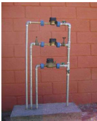
Figura 1 – Montagem do cavalete múltiplo para a realização da prova
