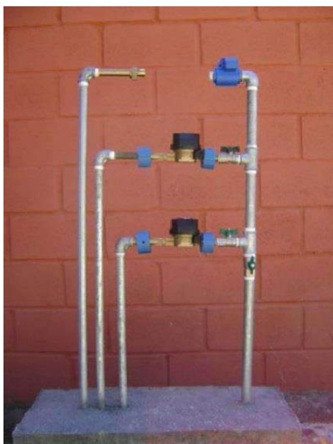
Figura G.2 – Montagem final da prova
