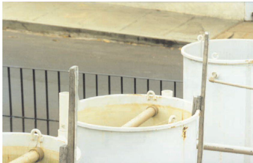
Figura 2 – Detalhe do tubo de coleta nos pré-filtros verticais de escoamento ascendente
