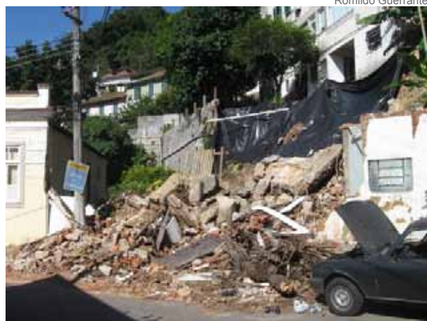
Este é o resultado de drenagem urbana sem controle
